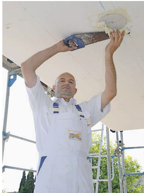
Außen- und Innenausbau gehören zum Leistungsspektrum.
