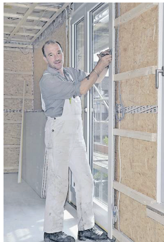
Die Firma Herz erstellt im Trockenbau auch leichte Trennwände.
